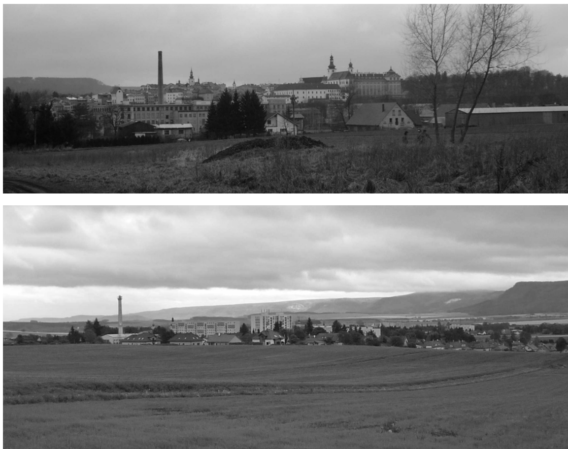
Obr. 3: Zatímco z východní strany si město Broumov zachovalo charakteristickou siluetu, kterou je možné ochránit mj. i prostřednictvím výškové regulace v územním plánu, ze severozápadní strany bude důležitější spíše přechod sídla do volné krajiny (Foto: V. Mikeš, 2008 a 2013)
