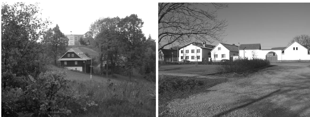
Nesoulad forem a měřítka staveb (hmoty, způsob zastřešení, šířky průčelí) narušuje v určitých situacích harmonické vztahy v zástavbě. (Foto Ivan Vorel)
