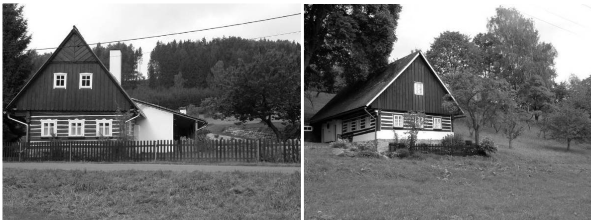
Hlavňov a Chlívce. Zdařilá rekonstrukce lomenic v Hlavňově je součástí souboru lidových stavení malebně usazených v terénu. Ves Hlavňov je v rámci preventivního hodnocení krajinného rázu zařazena do I. kategorie sídel a lokalit se zástavbou. Druhý snímek zachycuje lidovou architektura v závěru vsi Chlívce, která je zařazena do I. a II. kategorie (Foto: Atelier V, 2010)
